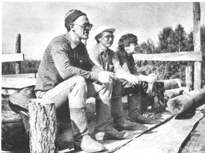
Д. Я. Резун, В. Н. Курилов, Л. А. Ткаченко на стройплощадке Спасской церкви г. Зашиверска в Историко-архитектурном музее под открытым небом Института археологии и этнографии СО РАН. Новосибирск, Академгородок
