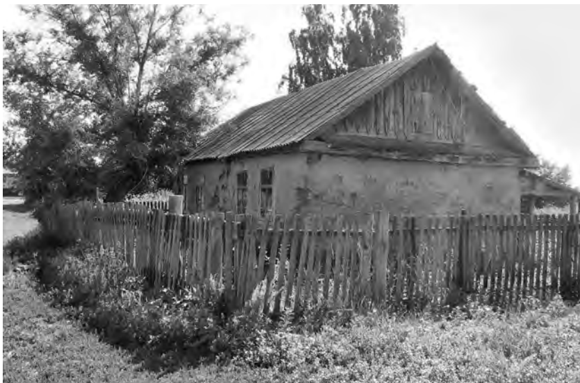
Рис. 23. Глинобитная хата 1950-х гг. постройки. Алтайский край, Романовский район, с. Дубровино. Материалы ИЭЭ 2010 г.
