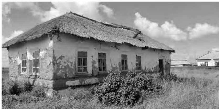
Рис. 25. Литая хата с камышовой крышей 1950-х гг. постройки. Новосибирская область, Карасукский район, с. Ирбизино. Материалы ЭЭ 2015 г.
